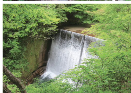
静の大滝 人工の堤防堰で落差は15mほど。なかなかの迫力。
