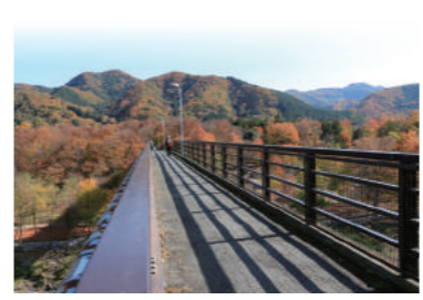
金石水管橋 歩行者と自転車のみ通れる橋。水道橋も兼ねている。
